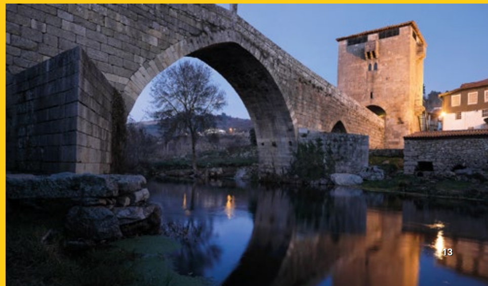
Torre e ponte Ucanha, Tarouca, Portugal
